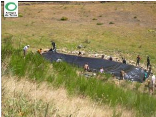
Fijación de base y laterales
