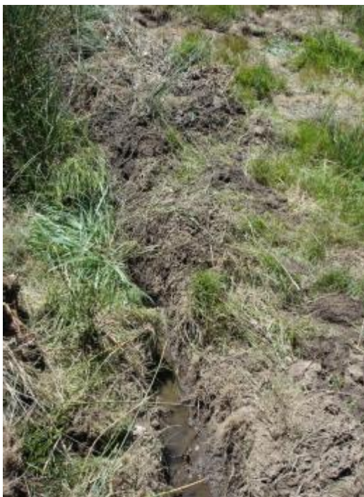
Zanja de desvío del Efluente de Salida de Fosa Séptica para evitar encharcamientos en la zona de excavación
