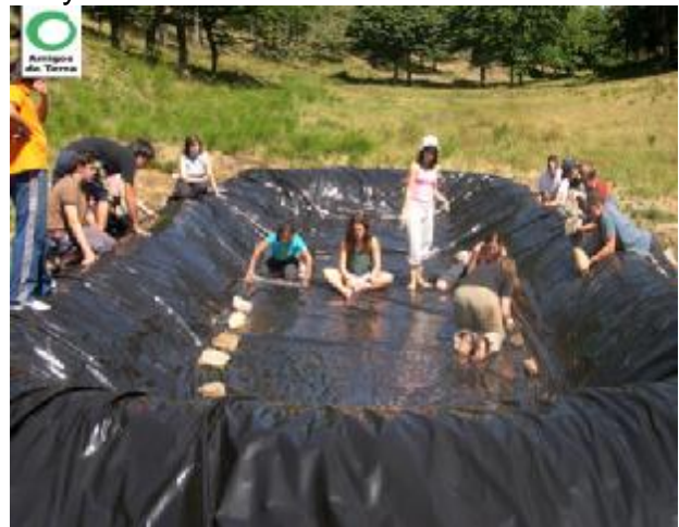
Fijación de base y laterales
